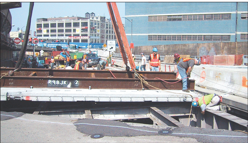
DeFoe crews ready to pour the concrete deck.
